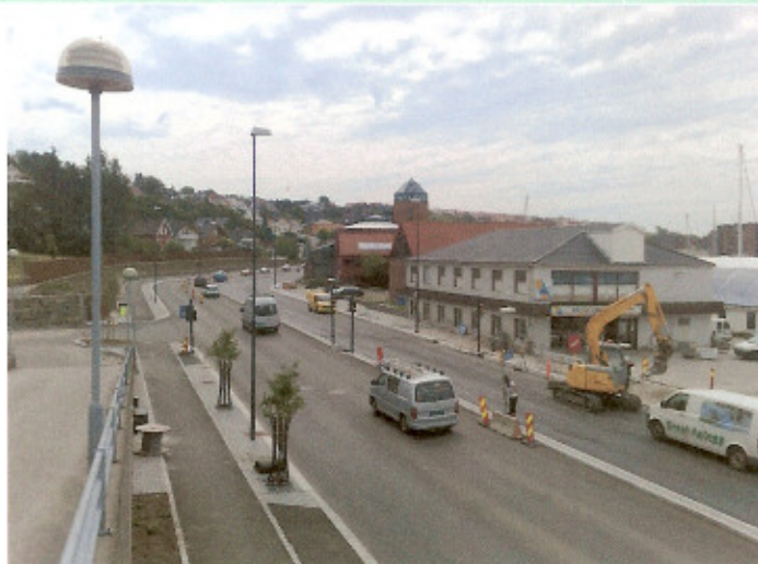
Anleggsarbeidet i Hanaveien i slutfasen
